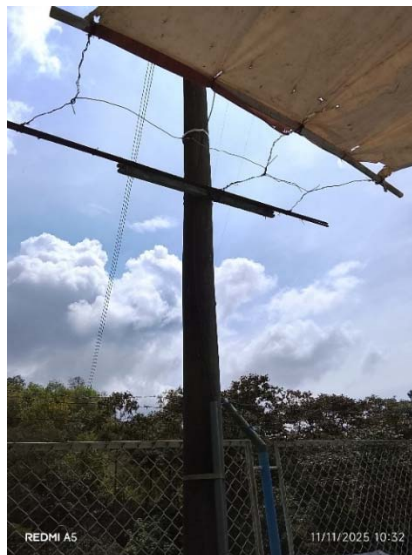
Imagen 13. Poste de energía en el cual se encuentra amarrada la cubierta improvisada.
