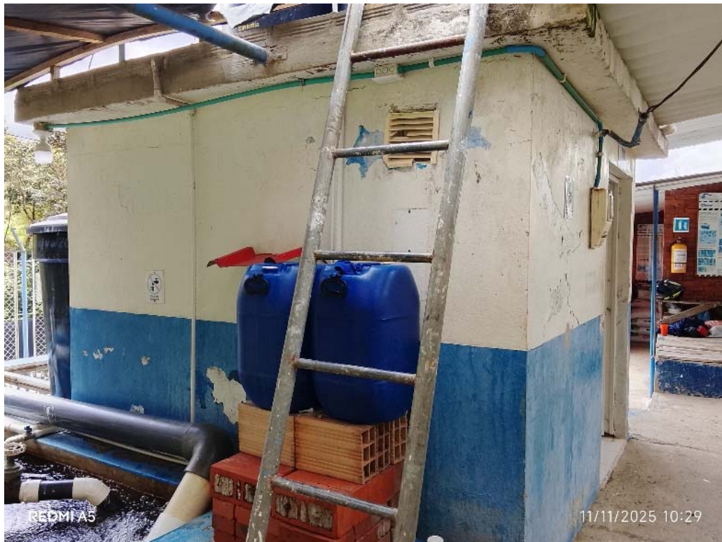
Imagen 10. Lugar de instalación de escalera.
