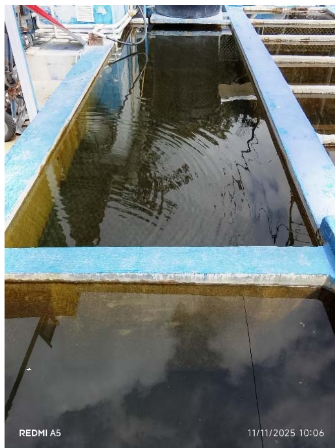
Imagen 8. Sedimentador
