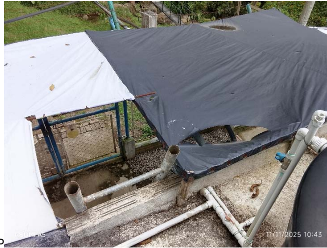
Imagen 12. Lugar de la cubierta a construir (reemplazando la improvisada de la imagen)
