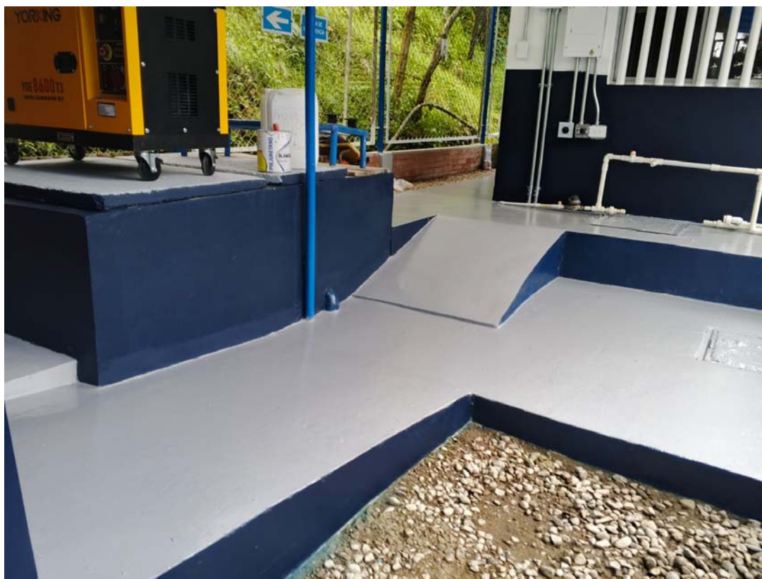
Imagen 6. Trabajos de recubrimiento de pisos y red eléctrica
