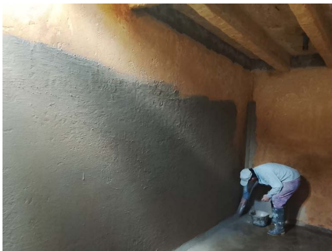
Imagen 5. Proceso de impermeabilización del tanque 2, vereda El Rosario, municipio de Tena.
