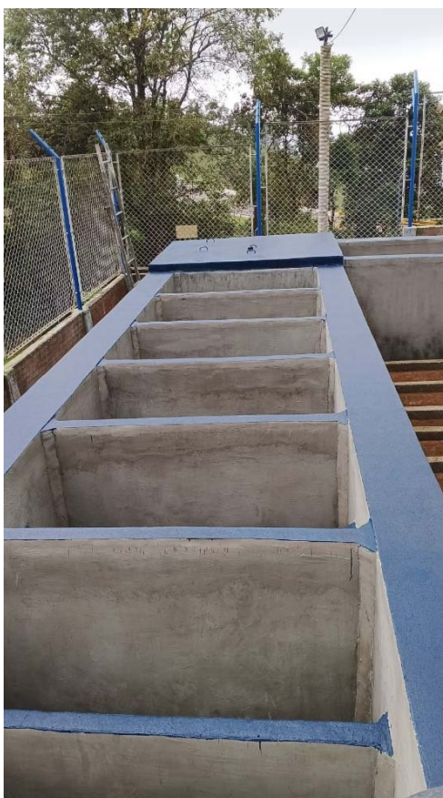
Imagen 7. Impermeabilización floculador y sedimentador
